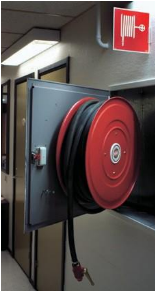
En vattenslang i styv plast är lätt att hantera och finns alltid på plats.
