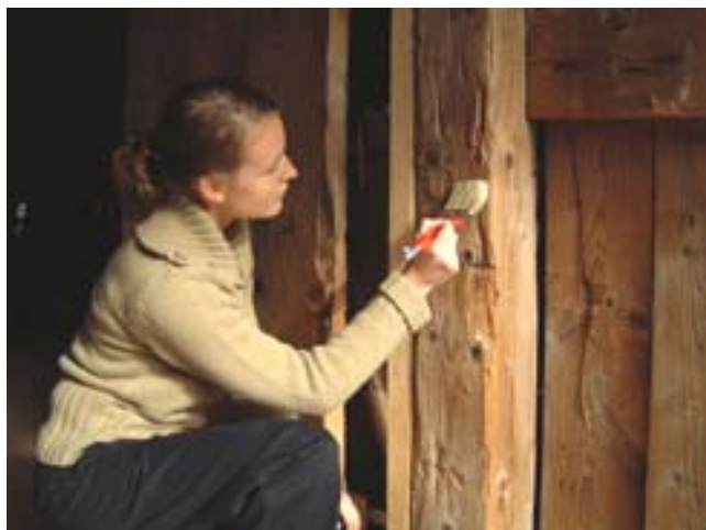
På trä påförs Exfire flamskyddsmedel enklast med pensel. Behandlingen ske två gånger.
